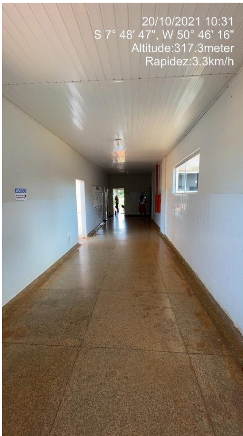
Imagens 43: Circulação Piso Manchado.
