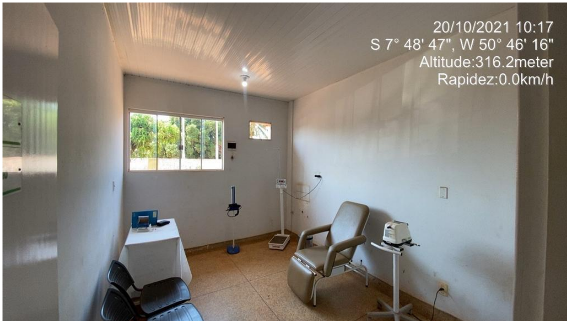
Imagens 10: Pintura danificada.
