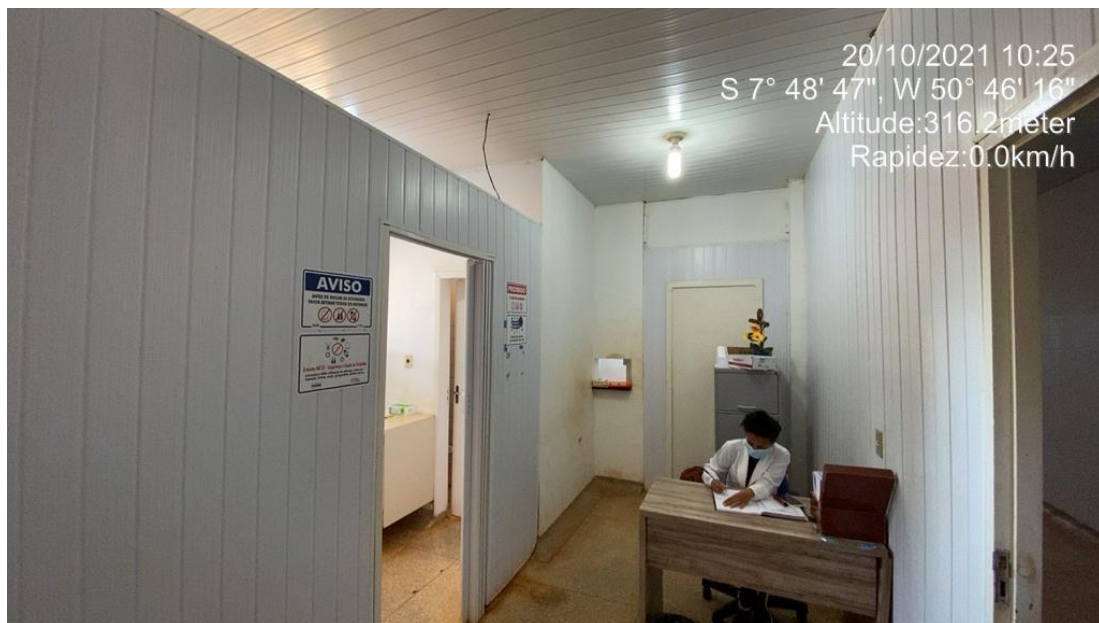
Imagens 33: Parede divisória de PVC.
