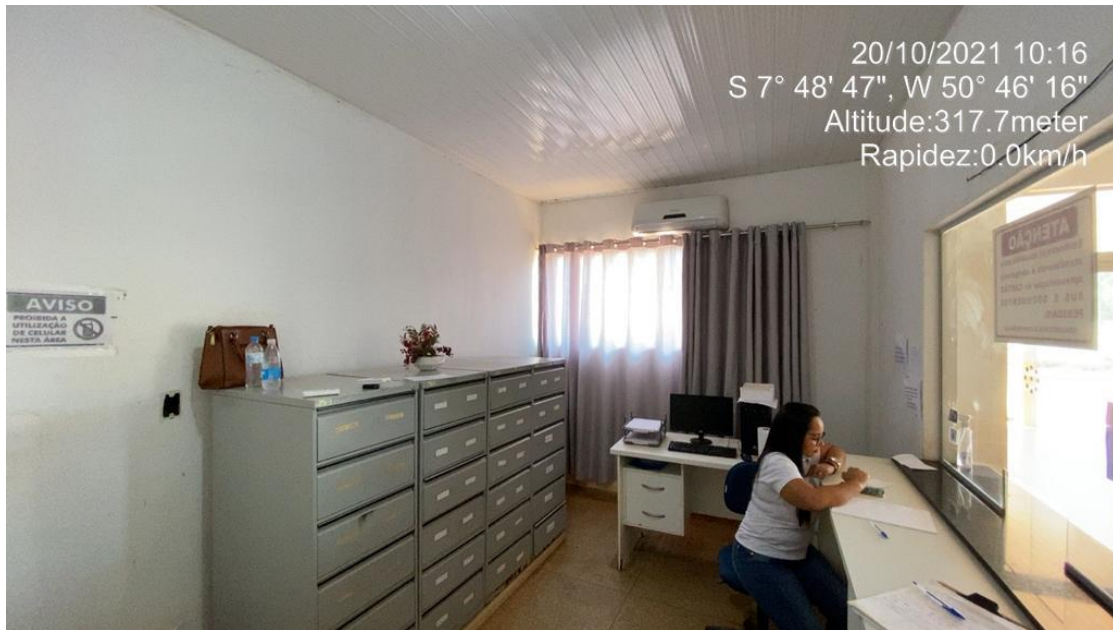
Imagens 06: Recepção Forro PVC.
