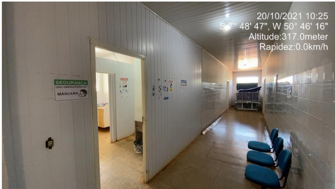
Imagens 32: Parede divisória de PVC.
